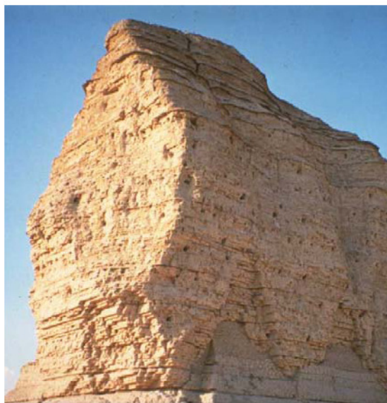
Rys. 1. Fragmenty gruntu zbrojonego wykonanego w Mezopotamii, 2000 p.n.e.,
