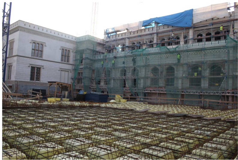
Zdjęcie 1. Zbrojenie stropu kasetonowego, fasada budynku dworca
